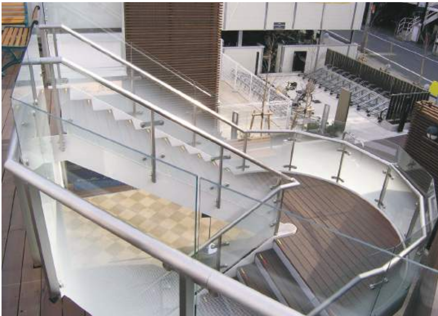
MH-GPS2060R MRG-C10-6TP (グラデーションフィルム貼り) 目黒区
